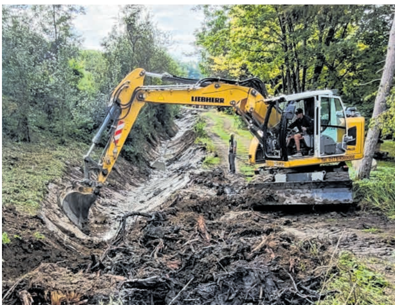
Reinigung des Sassengrabens in Büchold
