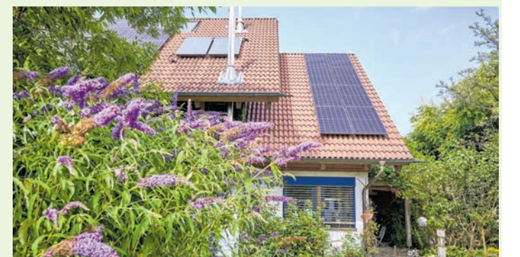
Die Dachfläche ist komplett ausgenutzt – mehr Solartechnik hätte keinen Platz gehabt.
