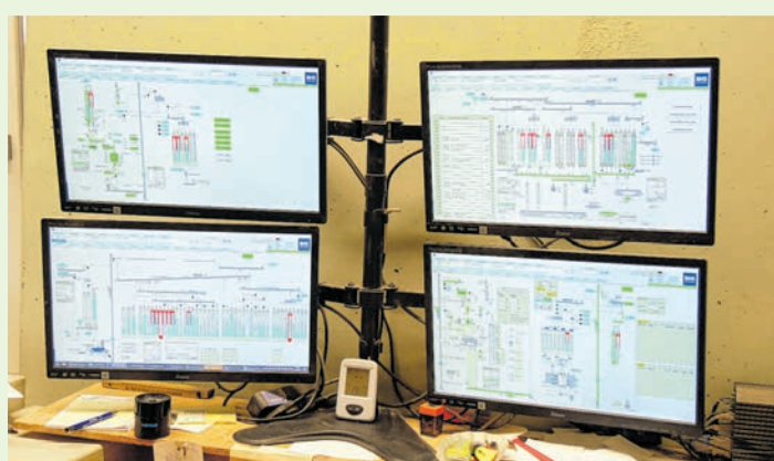
Als Müller arbeitet man viel mit den Händen und mit Maschinen. Aber im Biokraftfutterwerk Kaisermühle in Gänheim ist längst die moderne Technik eingezogen. Die Arbeitsabläufe und Füllstände werden in der Schaltwarte überwacht.
